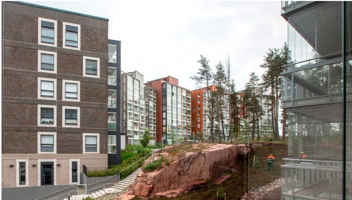
Espoon Asunnot rakennutti Olariin kolme 4–8-kerroksista taloa, joissa on 95 vuokra-asuntoa. Ensimmäiset asukkaat muuttivat kohteeseen toukokuun lopulla.
